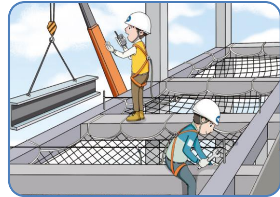
6 안전대 착용 시 안전대 부착설비 설치
